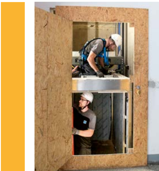
Bei der Erneuerung der Aufzüge wird die alte Technik vollständig durch neue Anlagenteile ersetzt.
