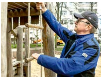
Henry Riedel kontrolliert die Seilaufhängungen und Sicherheitsverschraubungen an einem Klettergerüst.
